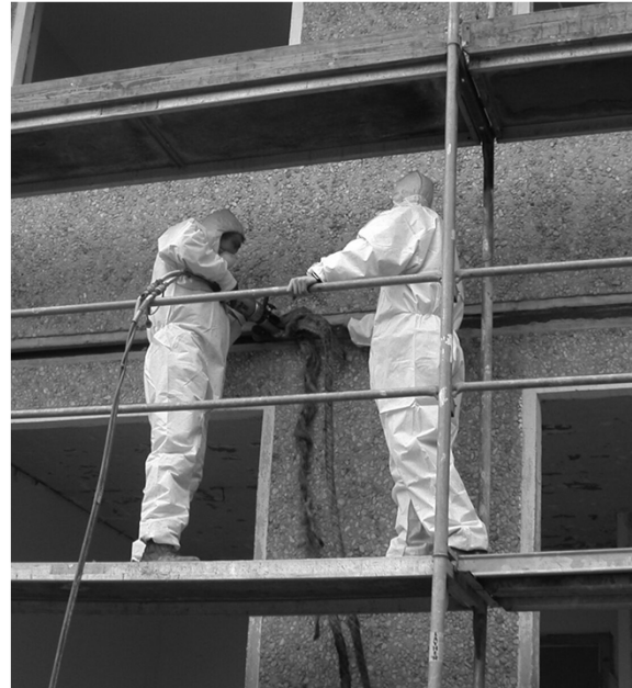
Ausbau des asbesthaltigen Dichtstoffes Morinol
